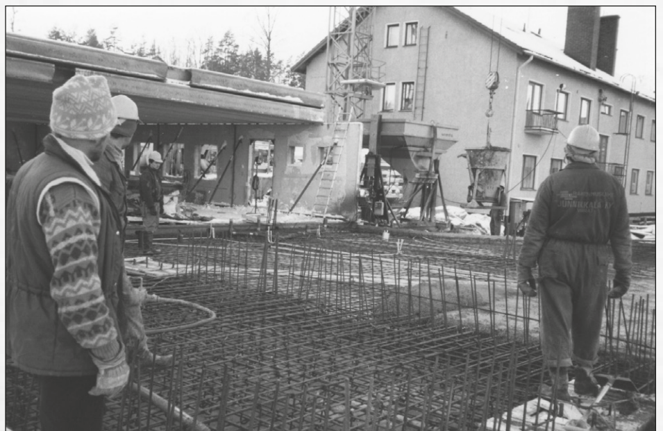
Ruoveden uuden pankkitalon perustustöitä tehtiin vuonna 1986.
