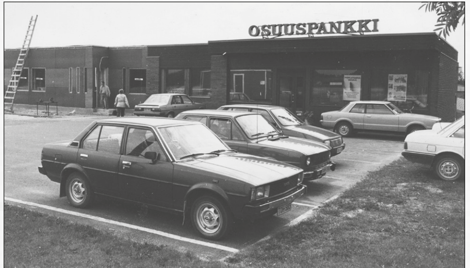
Kihniön nykyinen pankkitalo rakennettiin vuonna 1976.
